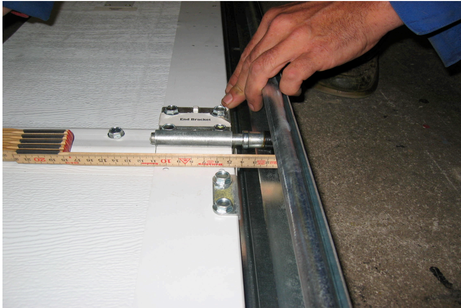
Bilde 1: Avstand mellom innvendig veggskinne og port element på mellomseksjoner.
