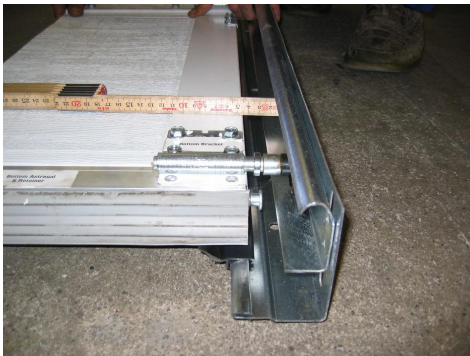
Bilde 1: Avstand mellom innvendig veggskinne og port element ca. 45mm.
